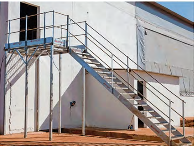
A PASSARELA: item fundamental nesse tipo de aviário, com plataforma na área externa para abastecimento de aves no período de alojamento e desalojamento.
